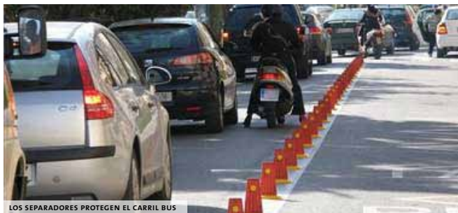
LOS SEPARADORES PROTEGEN EL CARRIL BUS
