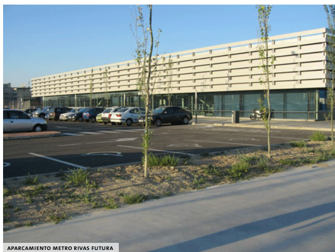
APARCAMIENTO METRO RIVAS FUTURA
