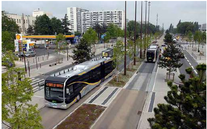
BUSWAY DE NANTES
